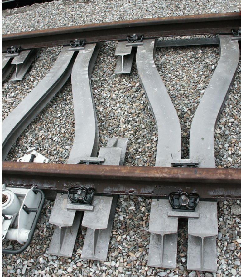
NEZAŠTRKOVANÉ OCEĽOVÉ PODVALY TYPU "Y"
