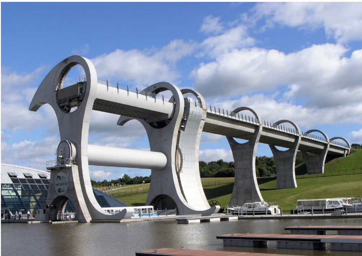
ROTAČNÉ LODNÉ ZDVÍHADLO VO FALKIRKU (UK) (Uvedenie do prevádzky 2002, výškový rozdiel 24 m, výkon motorov 22,5 kW)
