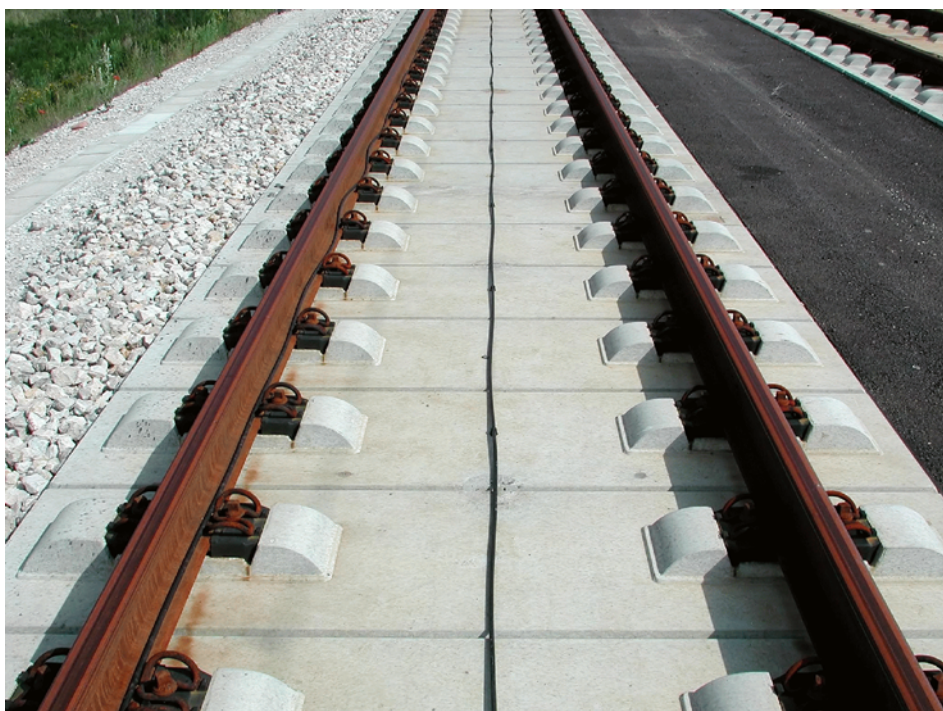
JEDNA Z KONŠTRKCIÍ KOĽAJE NA TZV. "PEVNEJ DRÁHE"
