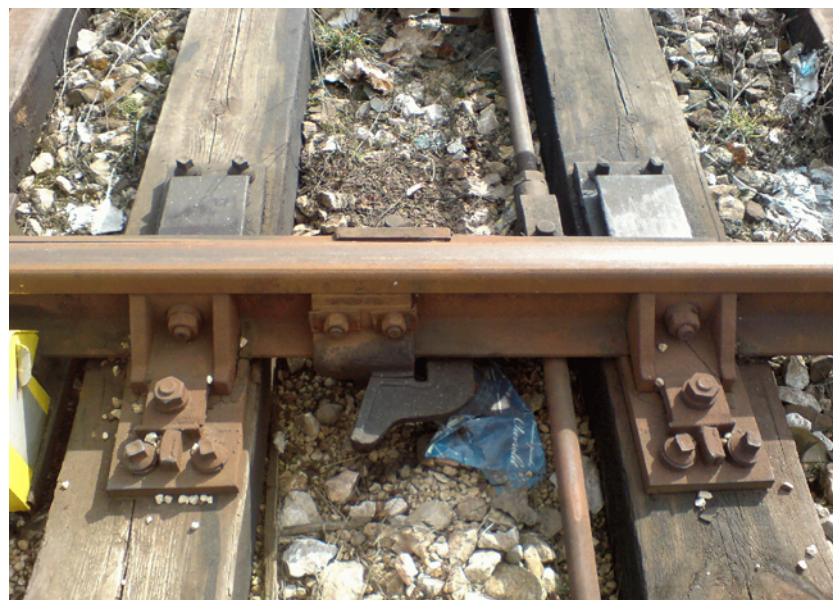
HÁKOVÝ UZÁVER VÝMENY (UZAMKNUTÝ)
