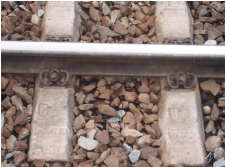
PRUŽNÉ UPEVNIENIE POUŽÍVANÉ NA ŽSR
