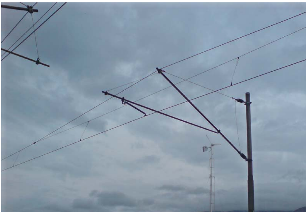
ZÁVES TRAKČNÉHO VEDENIA NA STĽPE
