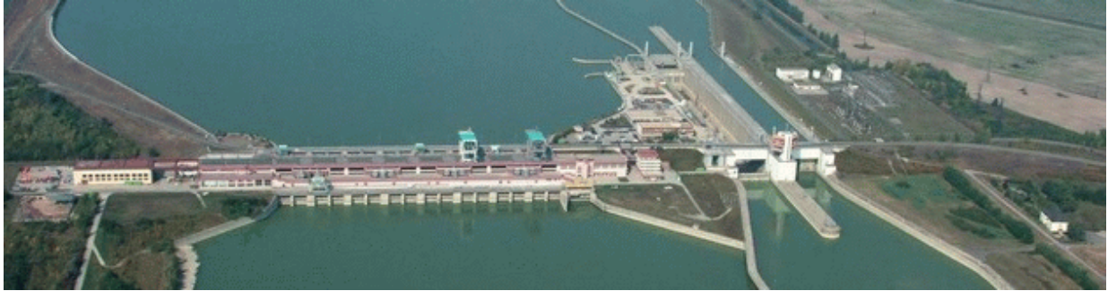
VODNÉ DIELO GABČÍKOVO S 2 PLAVEBNÝMI KOMORAMI
