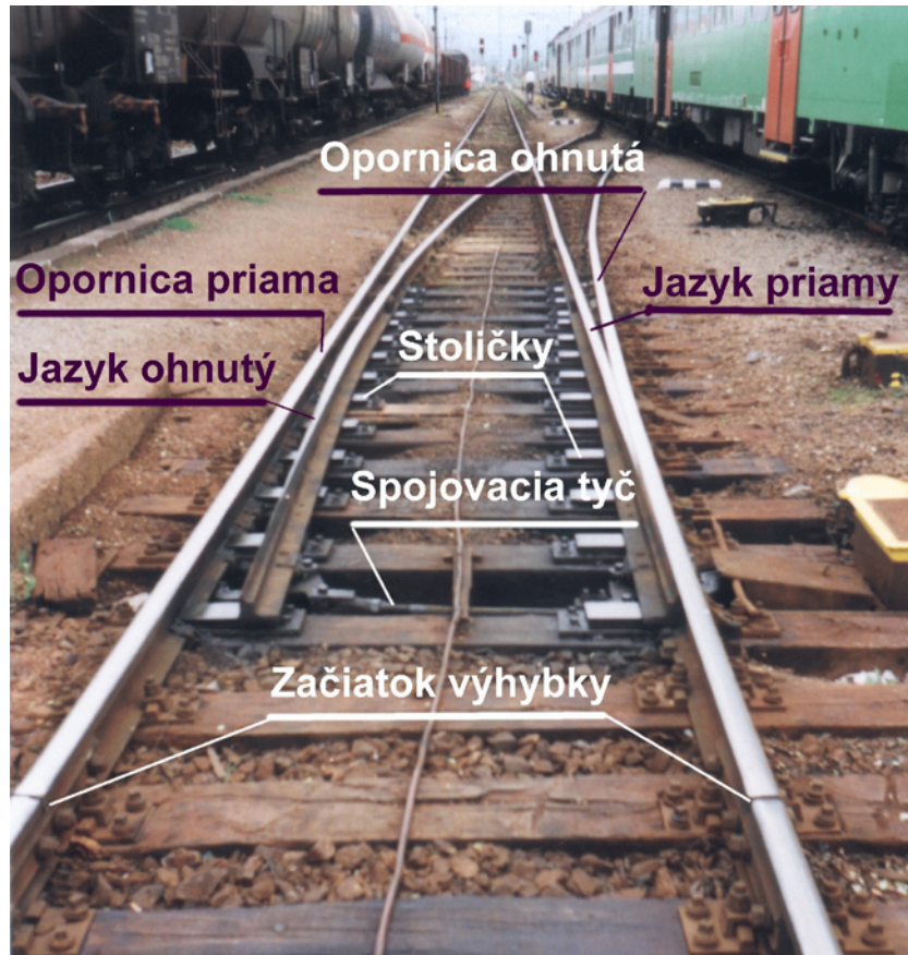
JEDNODUCHÁ VÝHYBKA V OBLASTI PRESTAVNÍKA
