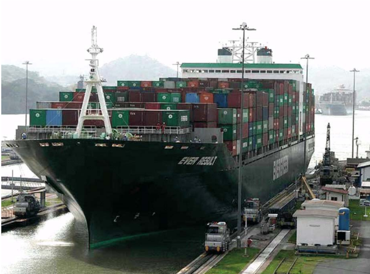
ŤAHANIE KONTAJNEROVEJ LODE V PLAVEBNEJ KOMORE PANAMSKÉHO PRIEPLAVU KOLAJOVÝMI MANIPULAČNÝMI PROSTRIEDKAMI (RUŠŇAMI)
