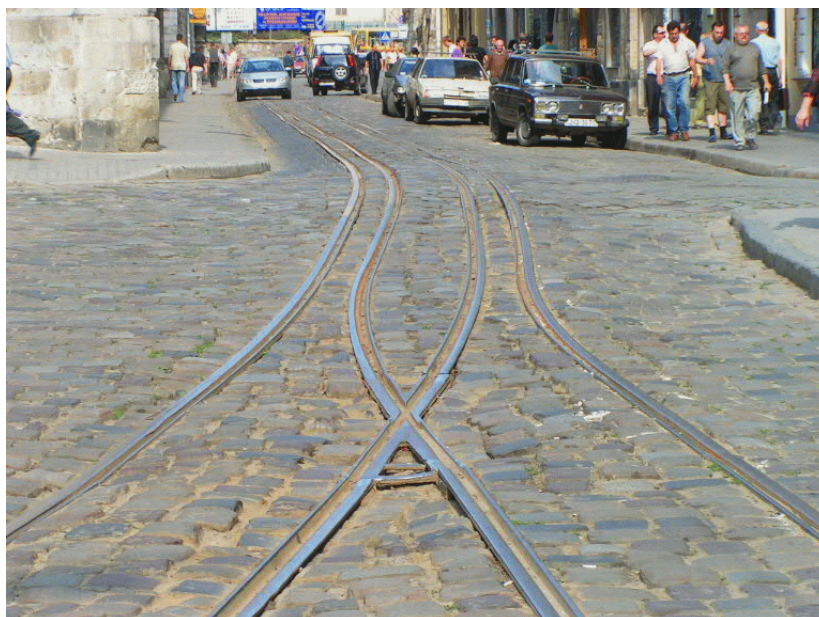
KOĽAJOVÁ SPLIETKA NA ELEKTRIČKOVEJ TRATI
