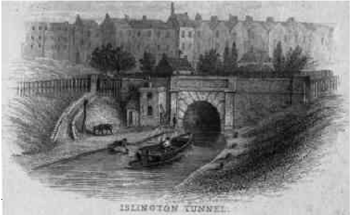
VODNÝ TUNEL ISLINGTON
