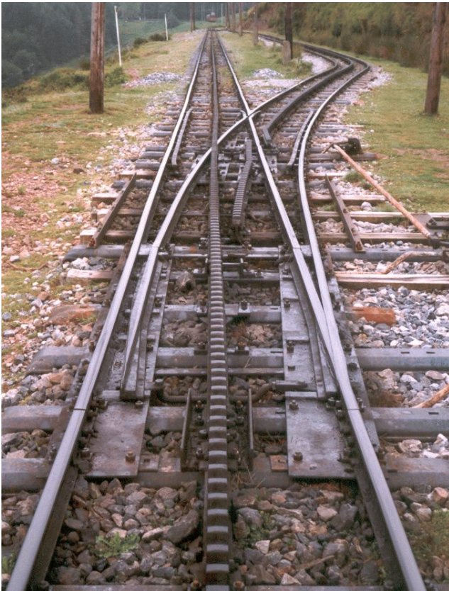
VÝHYBKA OZUBNICOVÉHO SYSTÉMU STRUBE PRIAMY SMER
