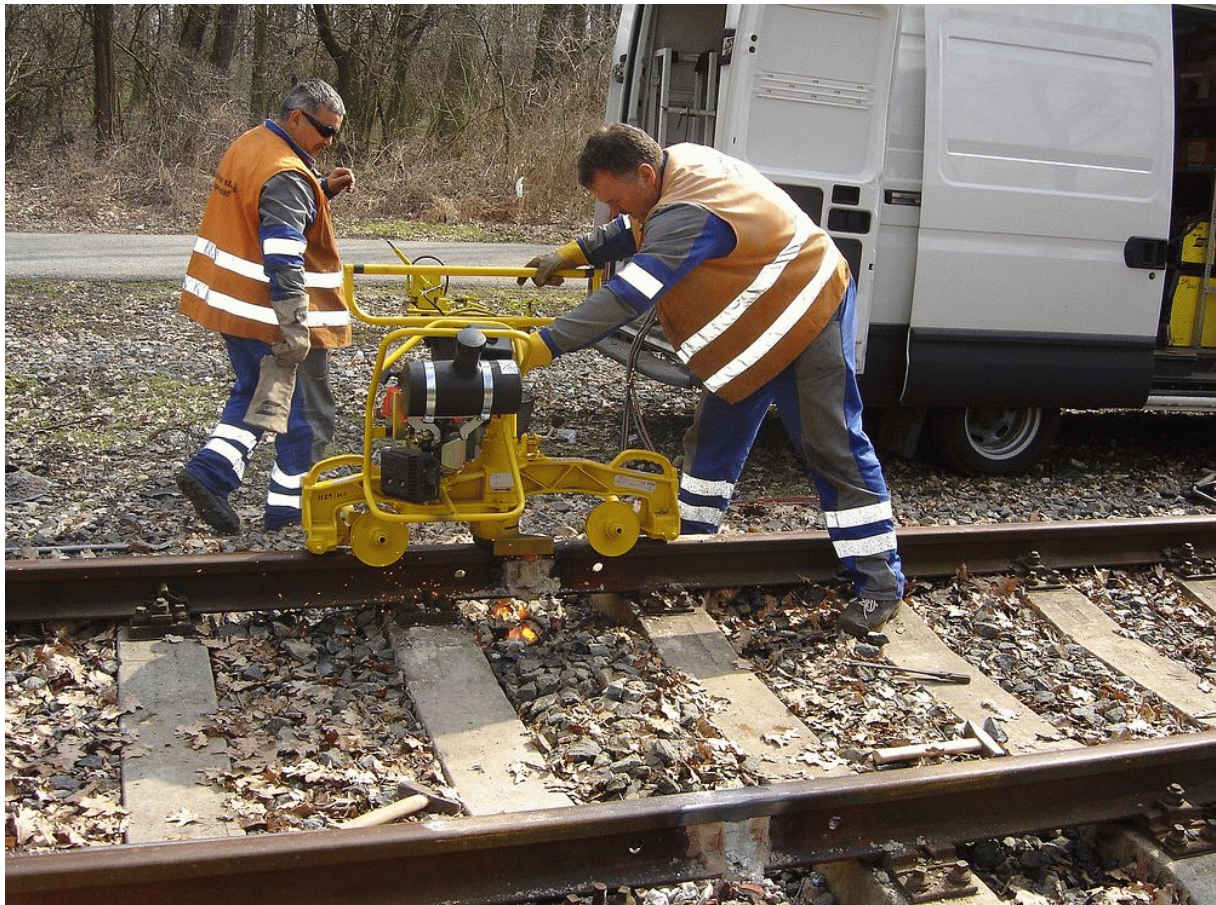
OBRUSOVANIE ZVARU KOĽAJNICE
