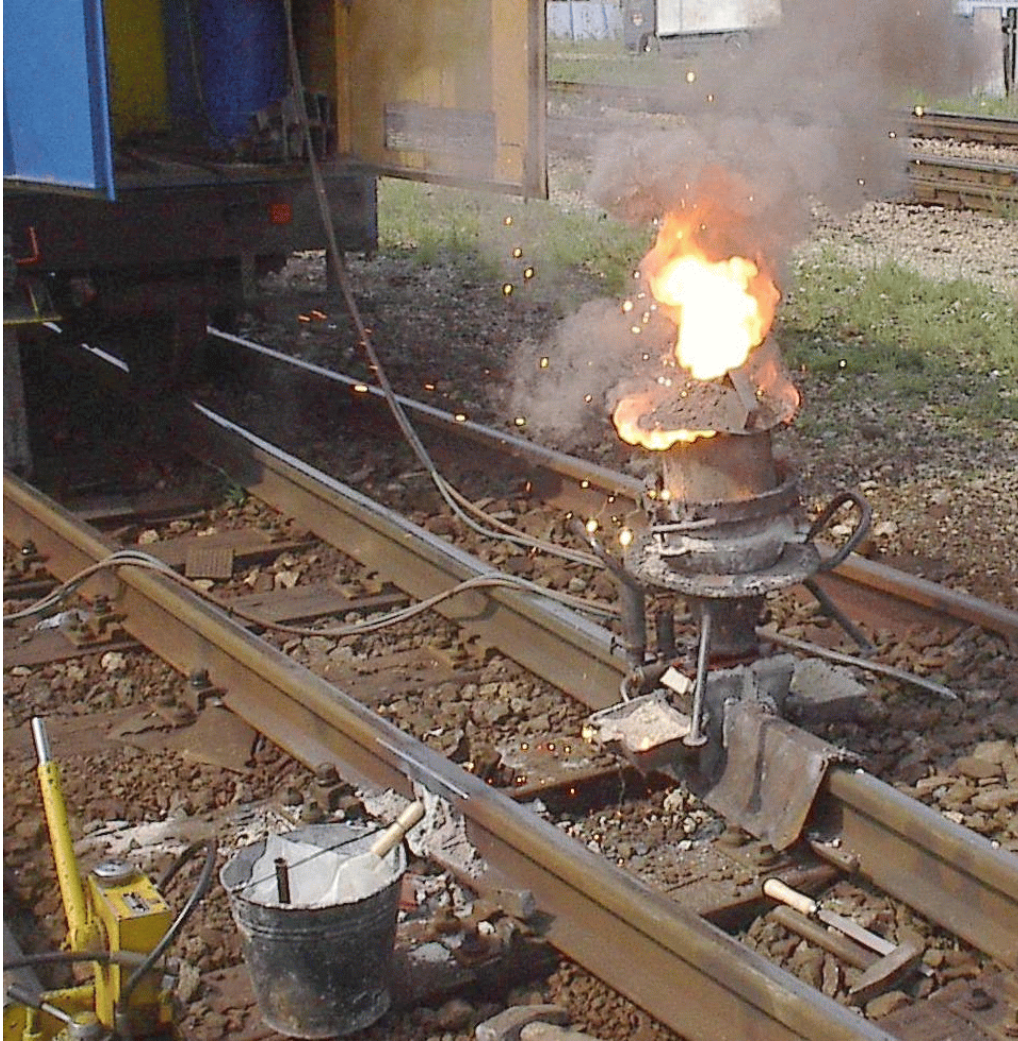
ALUMINOTERMICKÉ ZVAROVANIE KOĽAJNICE
